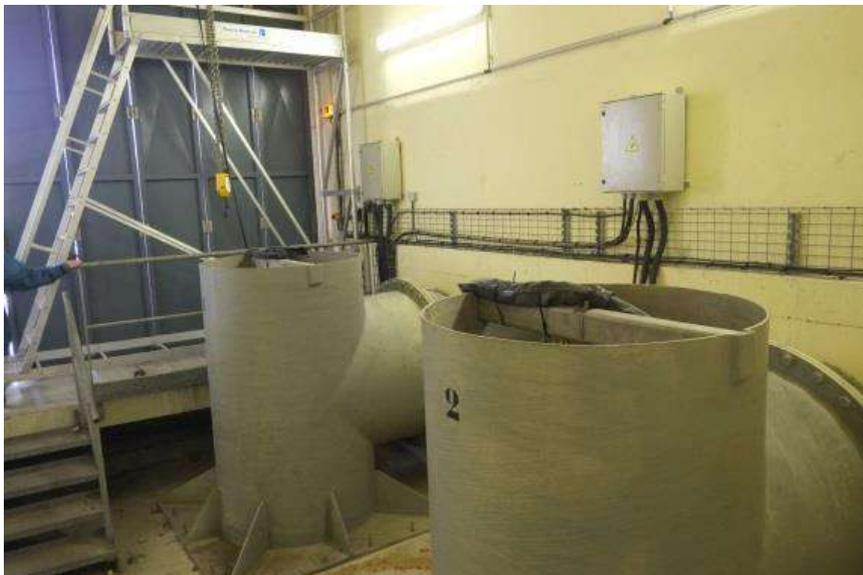
Figure n°9 : Station de la batellerie – Pompes Flygt.
